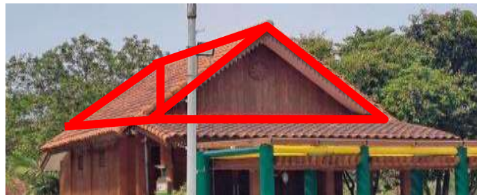
Gambar 9. Geometri Ruang pada Rumah Gudang Betawi
