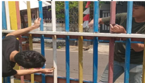
Gambar 1. Pengamplasan dan Pengelupasan Cat Lama
