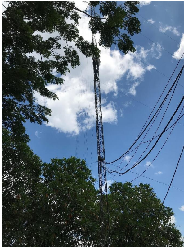
Gambar 13. Pemasangan Cambium Menara Kantor Mill
