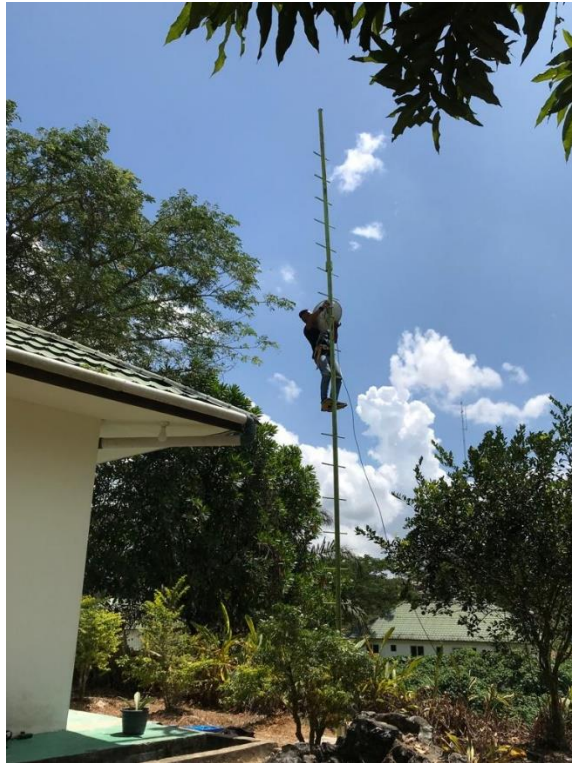
Gambar 12. Pemasangan Cambium Menara Mess Bod
