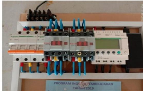
**Gambar 6. Pengujian MCB daya MCB Control Kontraktor**
